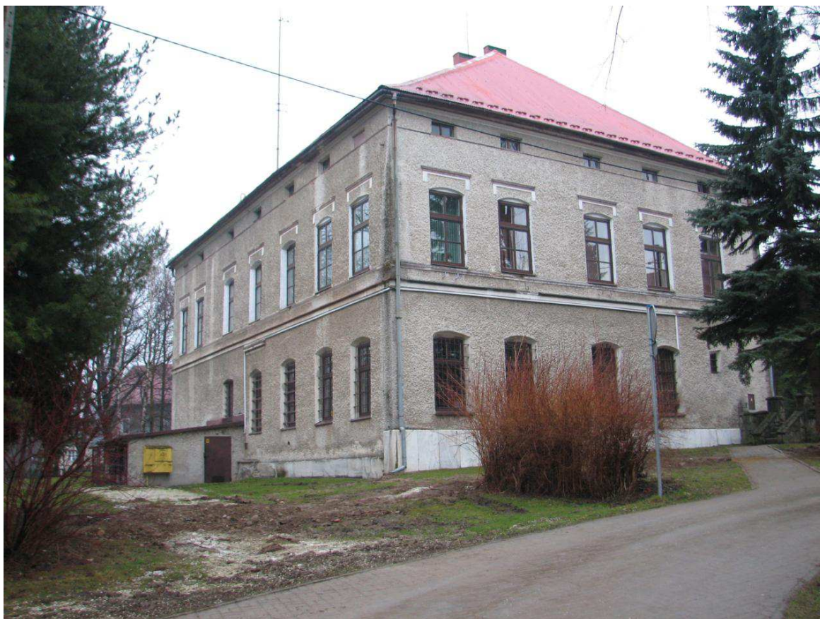
Widok budynku od tyłu (widoczne wejście do kotłowni gazowej).
