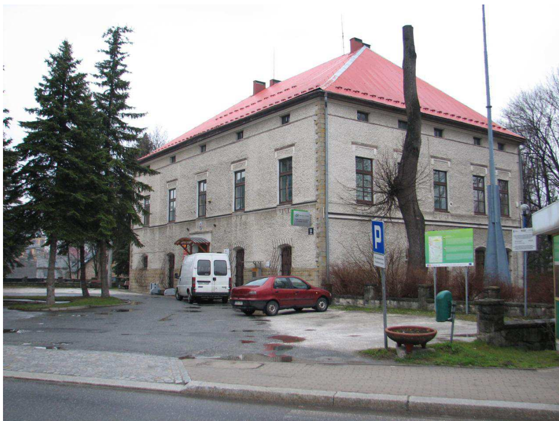
Widok budynku od frontu.
