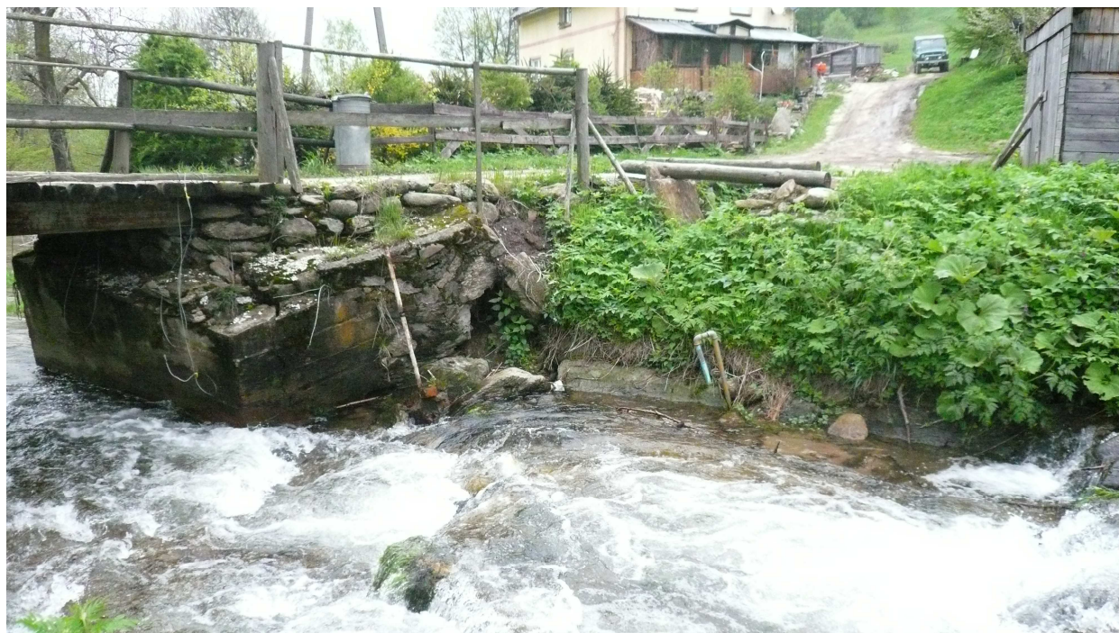
Fot. 4. widok od strony górnej wody z drogi powiatowej.
