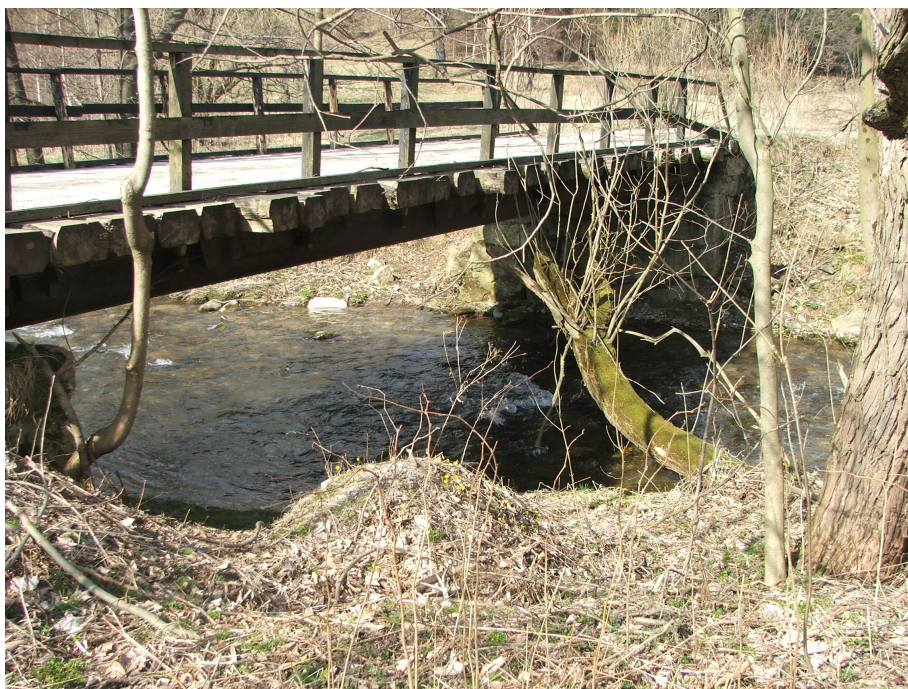
Fot. 3 - widok od strony górnej wody.
