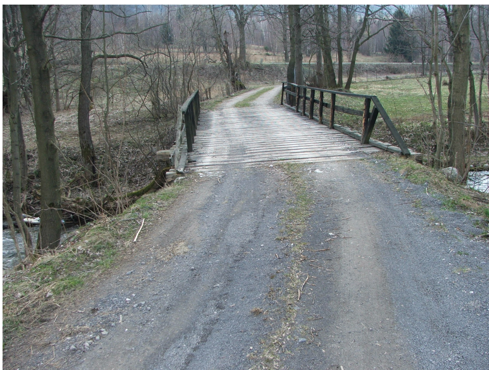
Fot. 2 - widok od strony drogi dojazdowej dz. nr 244.
