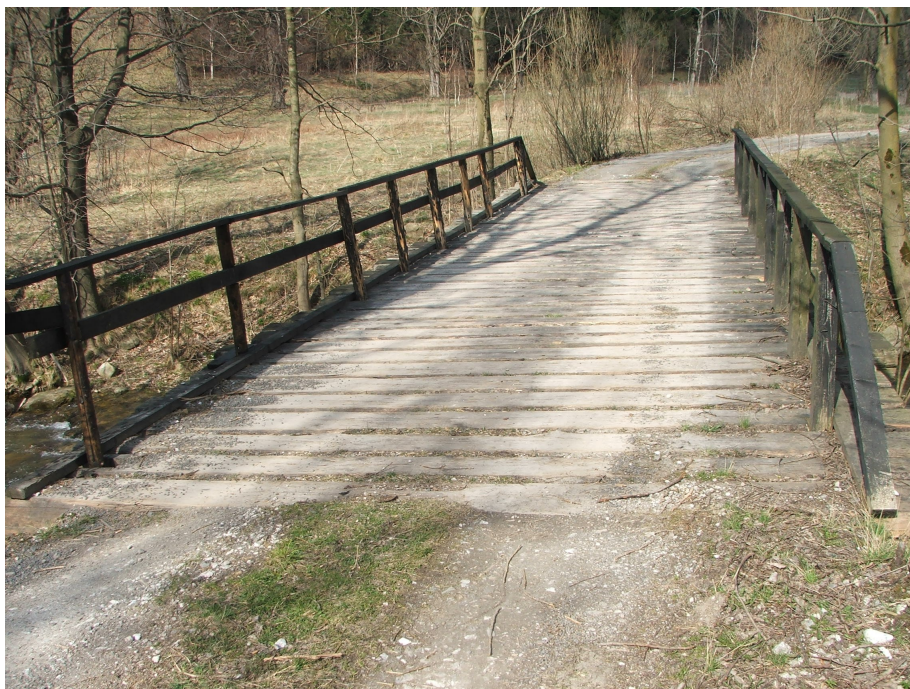
Fot. 1 - widok od strony drogi dojazdowej dz. nr 237.
