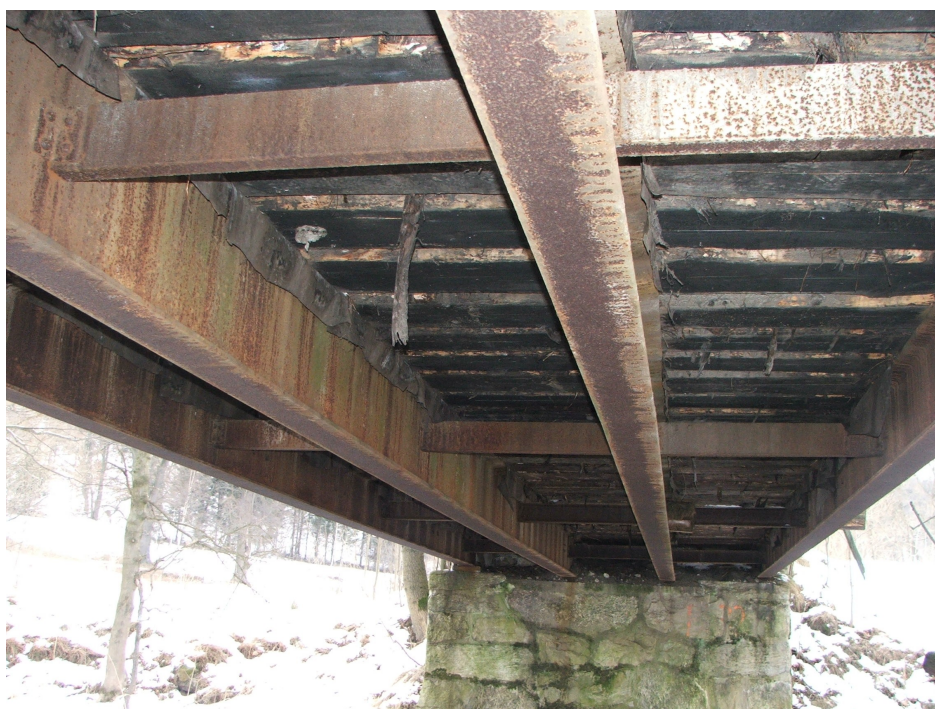
Fot. 4. widok od spodu mostu.
