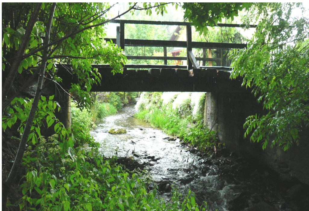
Fot. 2 - widok od strony dolnej wody.
