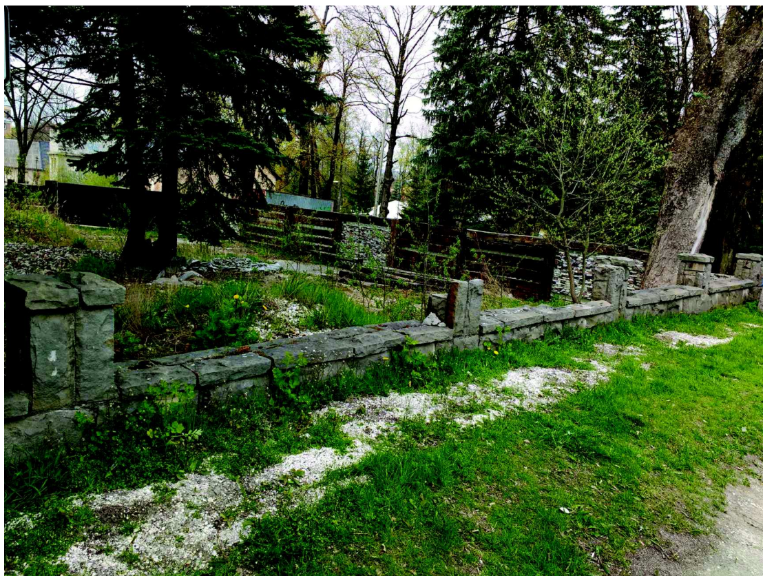
Ogrodzenie placu przed Urzędem - murek „północny”
