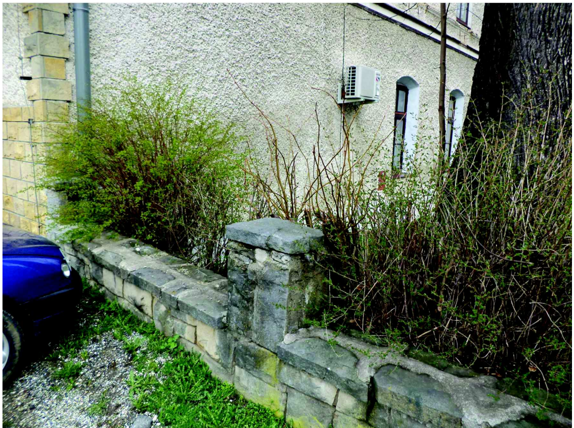
Murek południowy do rozbiórki
