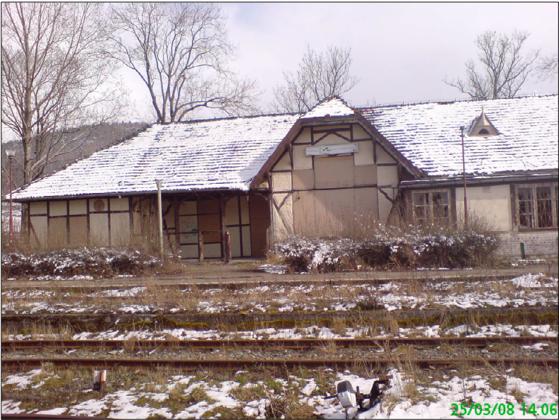
ELEWACJA TYLNA DWORCA PKP
